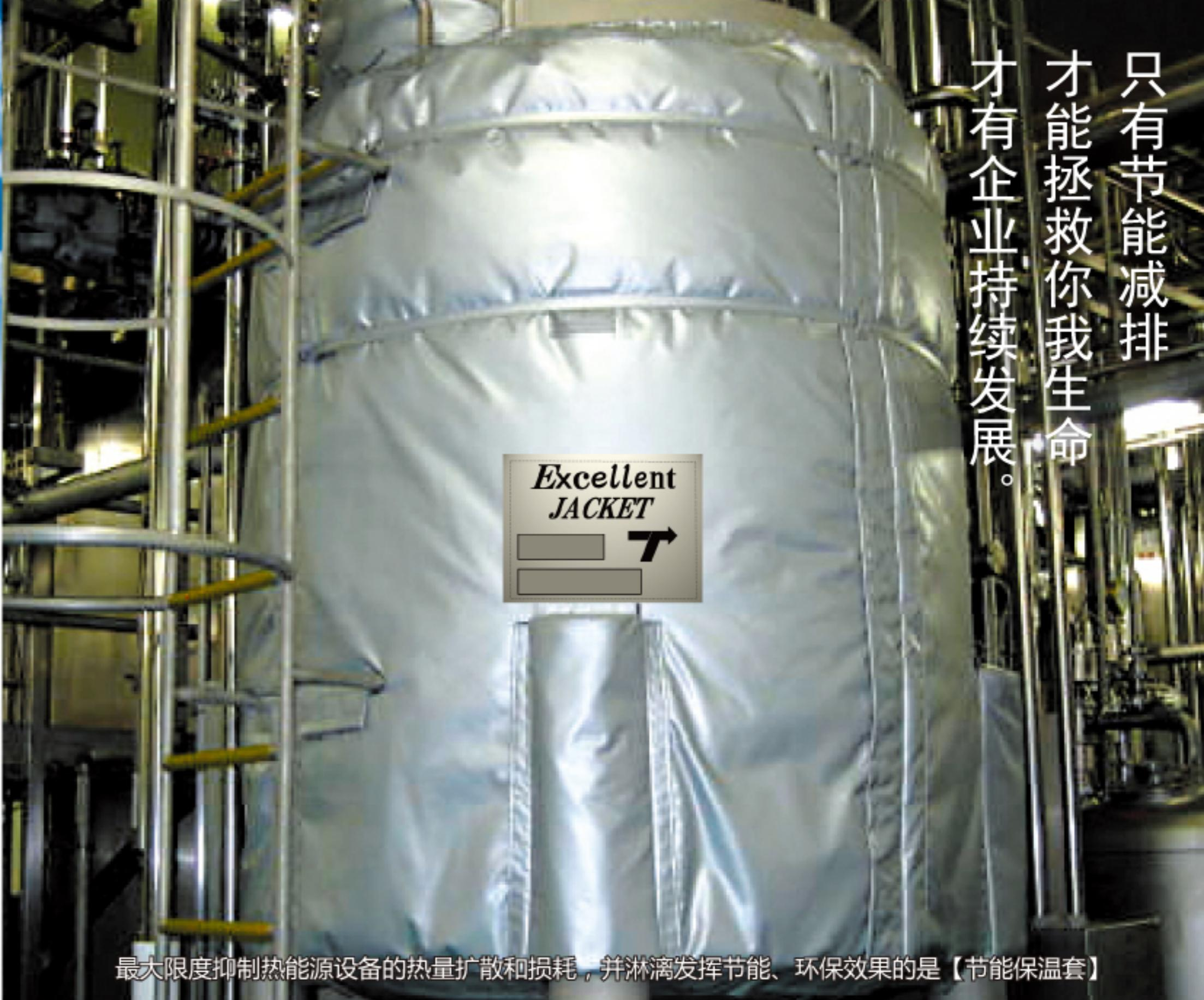
最大限度抑制热能源设备的热量扩散和损耗，并淋漓发挥节能、环保效果的是【节能保温套】
