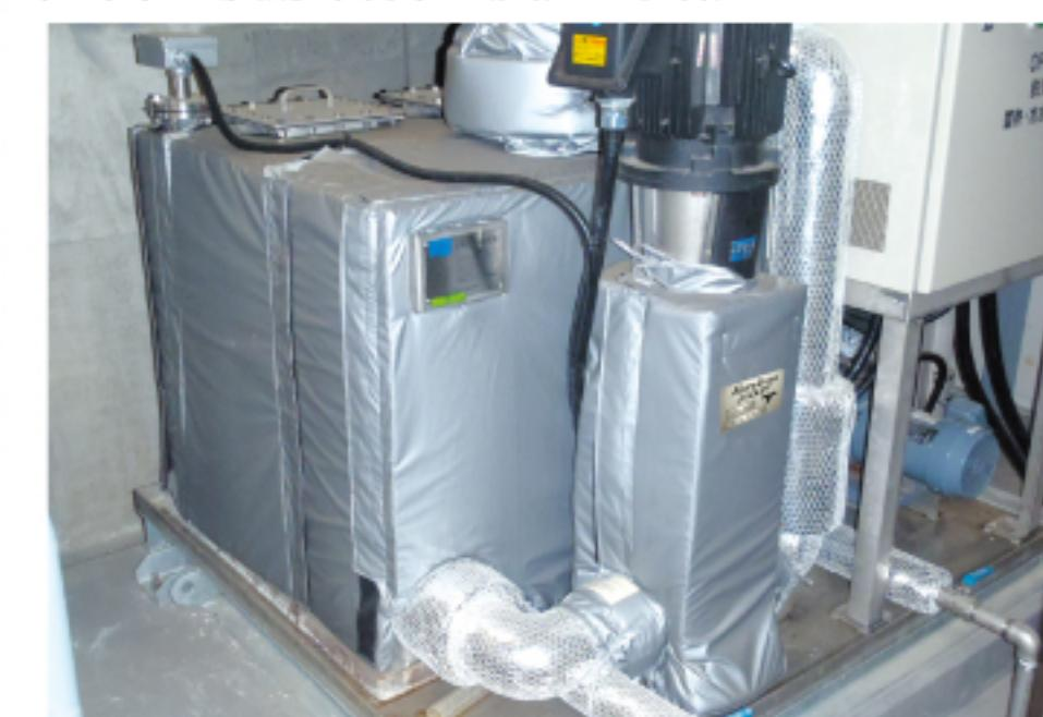
外材、内材：铝合金玻璃布、PVC篷布、聚乙烯 隔热材：白色玻璃纤维针刺毡、玻璃棉、岩棉、发泡聚乙烯、聚氨酯 缝线：肠丝、不锈钢线 结合部：尼龙搭扣 ( PA66 )
