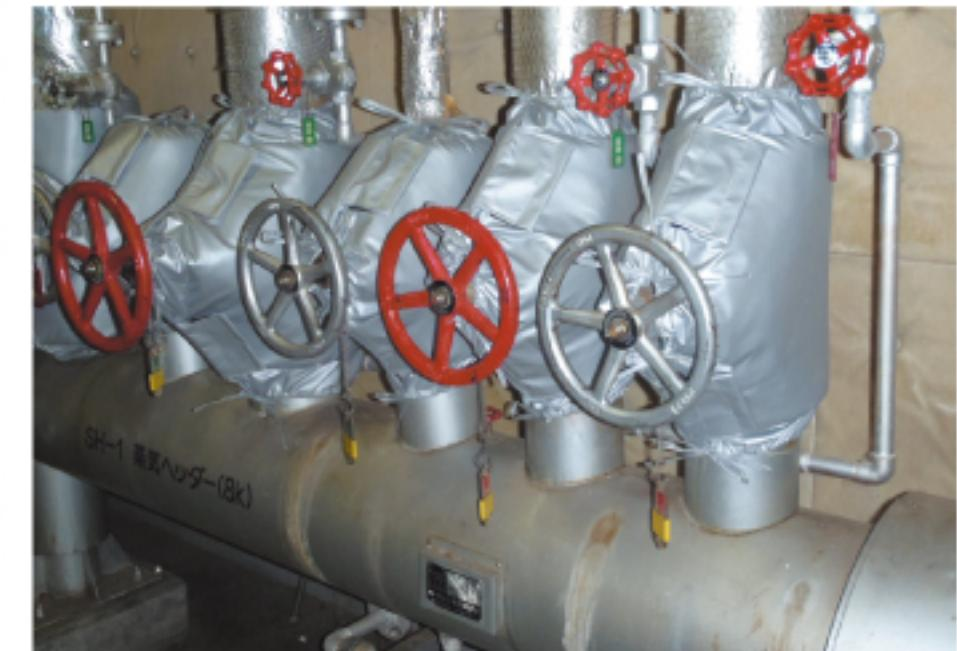
外材、内材：玻璃硅胶布、隔热硅胶布、玻璃特氟龙纤维、硅胶布 隔热材：白色玻璃纤维针刺毡、玻璃棉、岩棉、石英棉 缝线：玻璃特氟龙线、Nomex纤维线、不锈钢线 锁扣：尼龙搭扣 ( PA66 )
