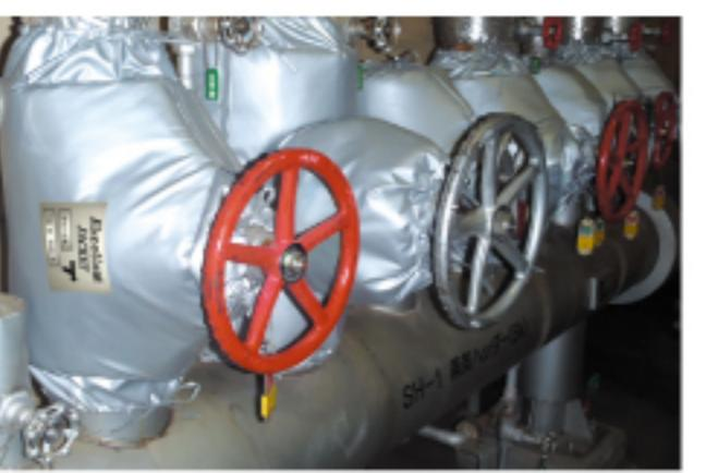
面对从蒸汽阀到电器炉，从成型机到冲压机等等的多跨行业，拥有业界丰富实绩的东伸集团将会根据每一个能源设备的形状，为您量身定制、并安装节能保温套；同时为削减电力使用量，实现成本降低作出规划和提案。
